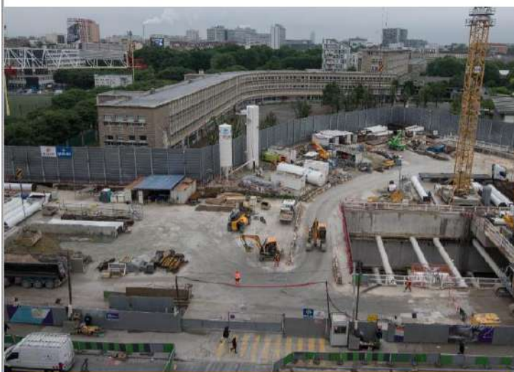
M14 : écrans acoustiques à Porte de Clichy (lycée Balzac) et Pont Cardinet
